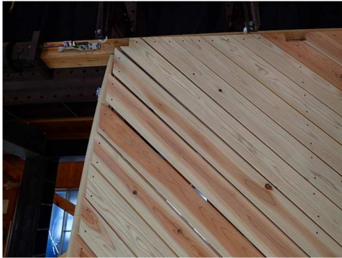
写真 2.2.3 板材間の隙間 (1/15rad 時)
